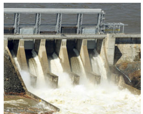
Đập thủy điện Mactaquac, Canada
