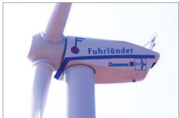
Cụm tuabin và cánh quạt nặng 85 tấn tại nhà máy điện gió Tuy Phong - Bình Thuận
